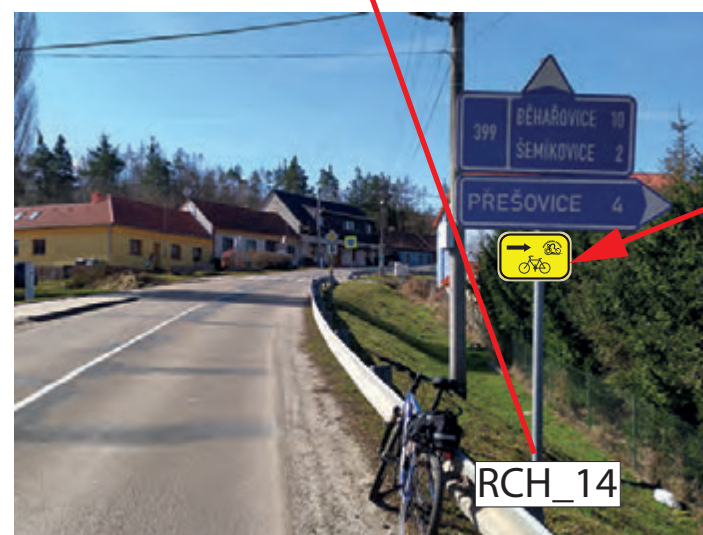
INSTALACE IS21c (MLYNÁŘSKÁ) NA SLOUPEK DOPRAVNÍHO ZNAČENÍ UMÍSTĚNÍ POD STÁVAJÍCÍ ZNAČENÍ
