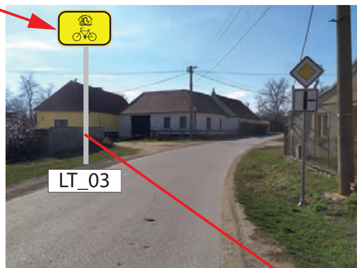
INSTALACE 2x IS21a (MLYNÁŘSKÁ) NA NOVÝ SLOUPEK SPOLEČNÝ PRO OBA SMĚRY V KOTEVNÍ PATCE POZEMEK: PARC. Č. 385/1, K. Ú. LITOVANY (OBEC LITOVANY)
