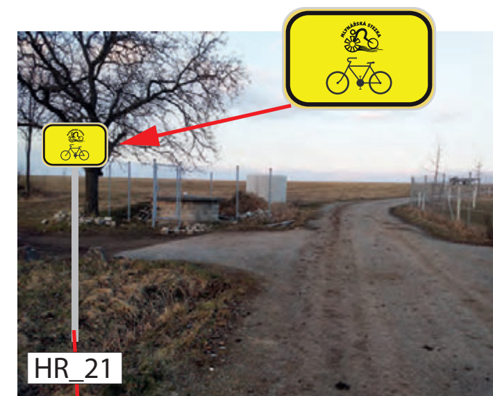
INSTALACE 2x IS21a (MLYNÁŘSKÁ) NA NOVÝ SLOUPEK SPOLEČNÝ PRO OBA SMĚRY POZEMEK : PARCELA Č. 942/2, K. Ú. HROTOVICE (OBEC MĚSTO HROTOVICE)
