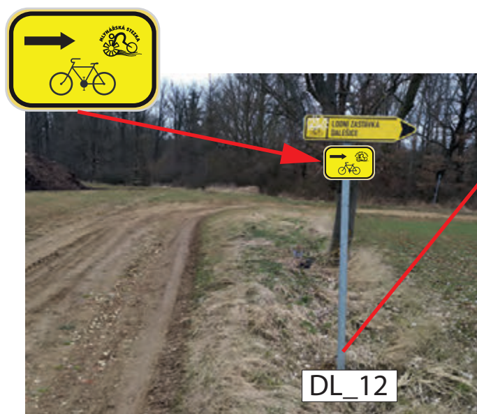
INSTALACE IS21c (MLYNÁŘSKÁ) NA STÁVAJÍCÍ SLOUPEK CYKLOTRASY UMÍSTĚNÍ POD STÁVAJÍCÍ ZNAČENÍ
