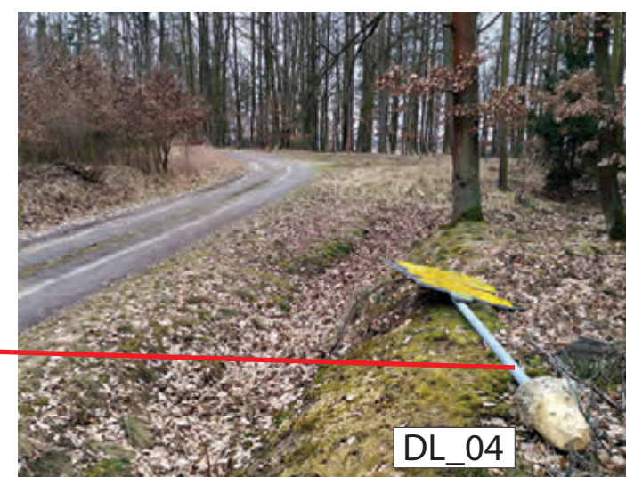
INSTALACE IS21b (MLYNÁŘSKÁ) NA STÁVAJÍCÍ SLOUPEK CYKLOTRAS OPRAVA INSTALACE SLOUPKU (VYVRÁCENÝ) NOVOU BETONÁŽÍ DO ZEMNÍ BETONOVÉ PATKY UMÍSTĚNÍ POD STÁVAJÍCÍ ZNAČENÍ
